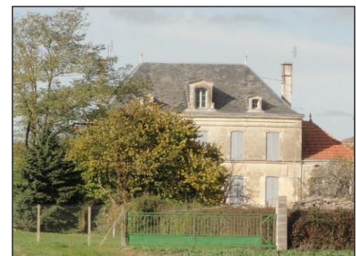
Maison de maître du XIX ème dotée d'une toiture à croupes en ardoises munies de lucarnes.
