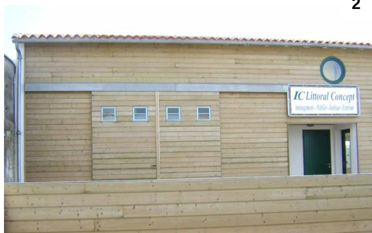
Bâtiment d'activité en bois
