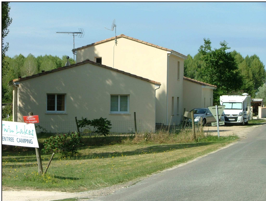
Nouvelle construction à La Faïencerie, vue de la voie communale n°13 Source : SIVOM du Canton de Montendre
