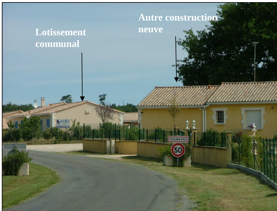
Nouvelles constructions à La Chagnasse Source : SIVOM du Canton de Montendre
