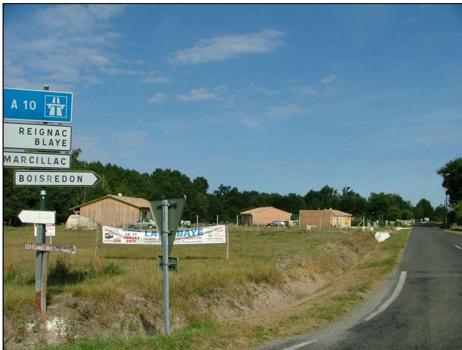
Deuxième lotissement privé aux Landes du Gablezac, vue de la RD19 Source : SIVOM du Canton de Montendre
