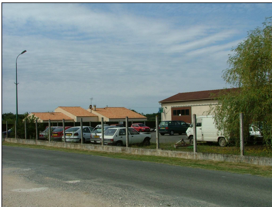
Garage situé au Grand Sable Source : SIVOM du Canton de Montendre
