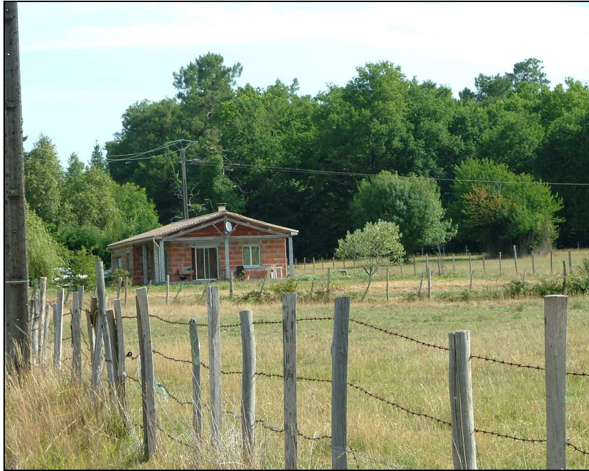
Nouvelle construction à La Mareauderie sur les parcelles B980 et 983, vue de la voie communale n°1 Source : SIVOM du Canton de Montendre
