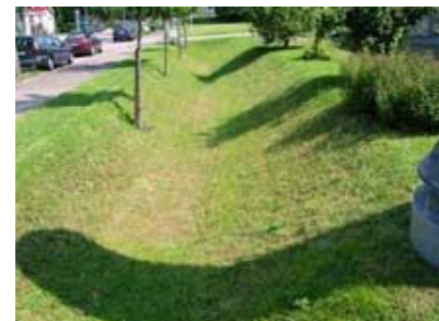
Noue enherbée accueillant les eaux pluviales, d'une largeur de 2 à 3 mètres
