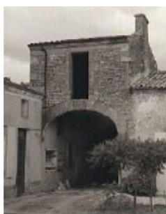
cellule charentaise avec, au dessous de la génoise, des trous de moineaux et des clous à mojhettes
