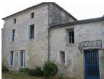
Fig. 1 Les façades sur rue.
