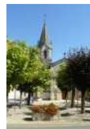
La façade occidentale de l'église.
