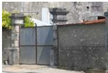
Fig. 2 Le portail à piliers.
