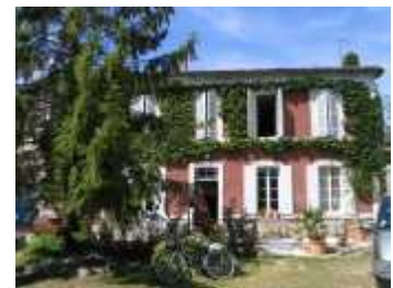
La façade sur cour du logement.
