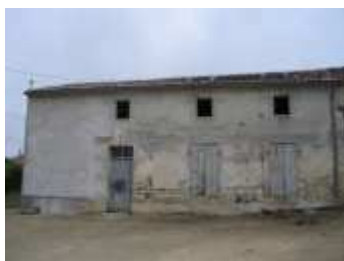
Fig. 10 Un des logements secondaires.
