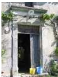
Fig. 2 La porte d'entrée du logement principal.
