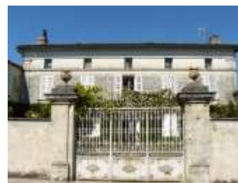
Le logement principal et le portail à piliers.
