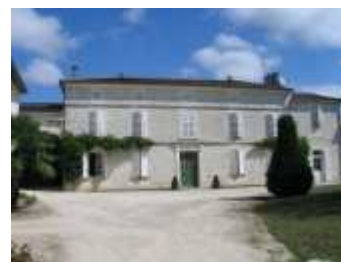
La façade sur cour du logement.
