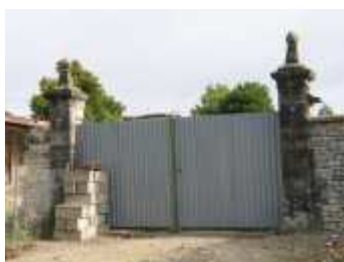
Fig. 4 Le portail à piliers.
