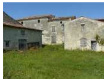
Les façades sur cour des bâtiments.
