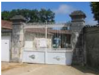
Fig. 8 Le portail à piliers.
