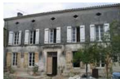
La façade sur cour du logement.
