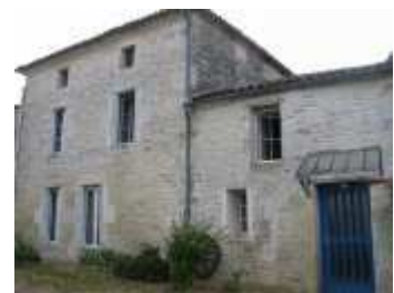
Les façades sur rue.
