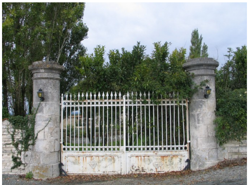
Portail à piliers cylindriques, 2 rue de Bellevue
