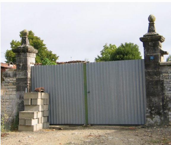
Portail à piliers, 6 allée du pigeonnier
