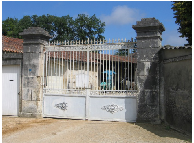
Portail à piliers, 11 rue des Cornières
