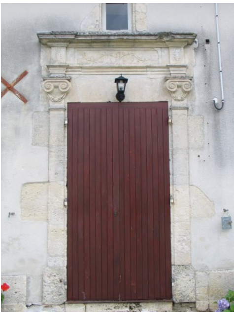
Porte d'entrée du logement, 2 rue de Bellevue
