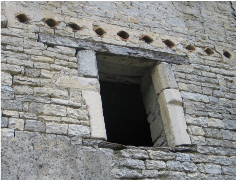
Détail d'une ouverture sur la ferme d'exploitation agricole, 11 rue du Négocé
