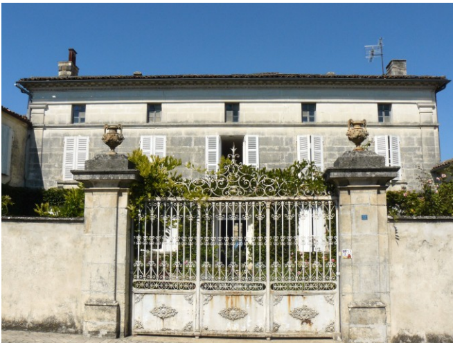
Logement principal et portail à piliers, 13 rue de la Distillerie
