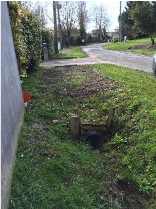
Figure 7 : vue du départ du réseau canalisé Chez Mouchet
