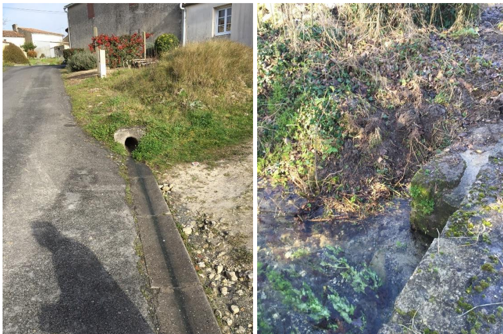
Figure 12 : vues d'un rejet superficiel du réseau et de l'exutoire du hameau
