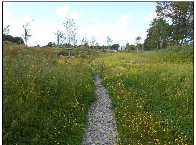
Figure 22 : ouvrage de régulation de plus de 2 m de profondeur accessible au public (Treillières – 44)
