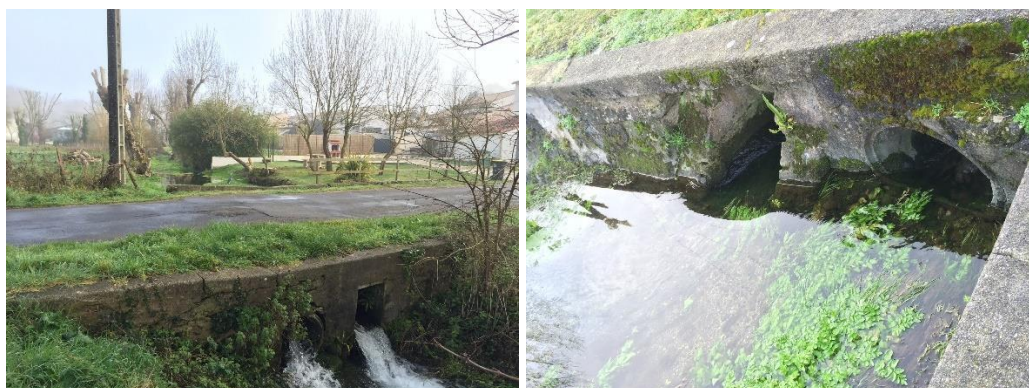
Figure 5 : vues des ouvrages de franchissement sur le Ruisseau de La Reine
