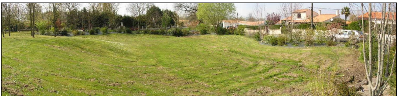
Figure 23 : ouvrage de régulation en quartier résidentiel accessible au public (Rochefort – 17)
