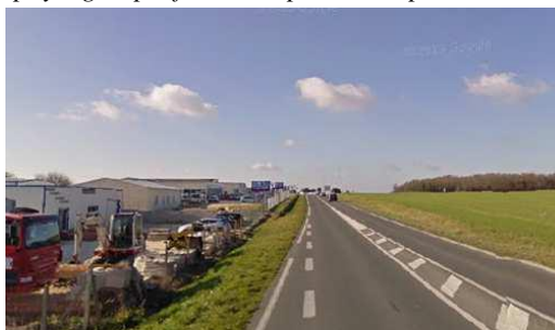
Vue sur l'arrière des bâtiments de la zone d'activités et le bois de La Valade
