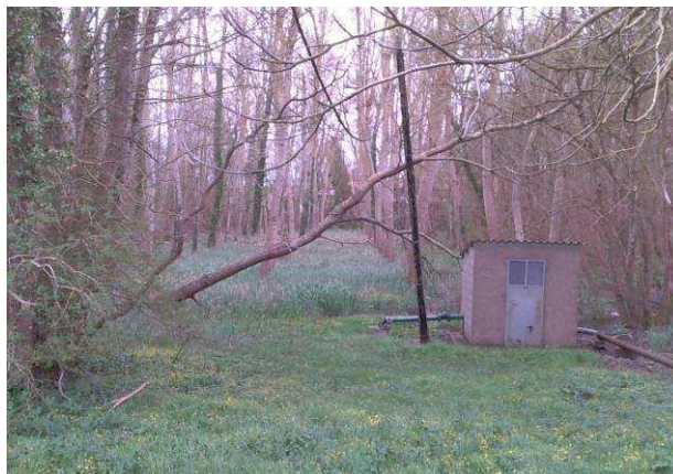
Peupleraie au droit du ruisseau de La Reine
