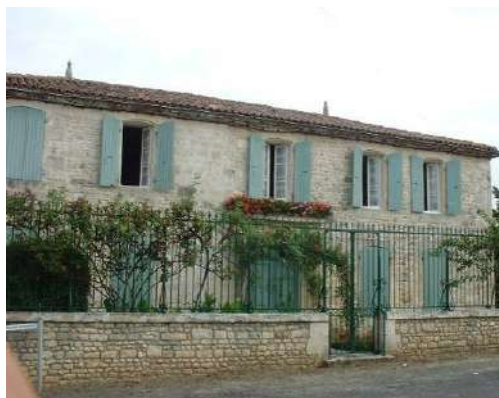
Clôture constituée d'un muret et de grilles ; ici aussi la végétation est présente
