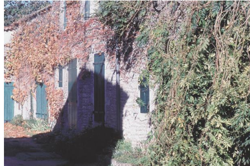
Protection végétale de la façade sud, Chéray
