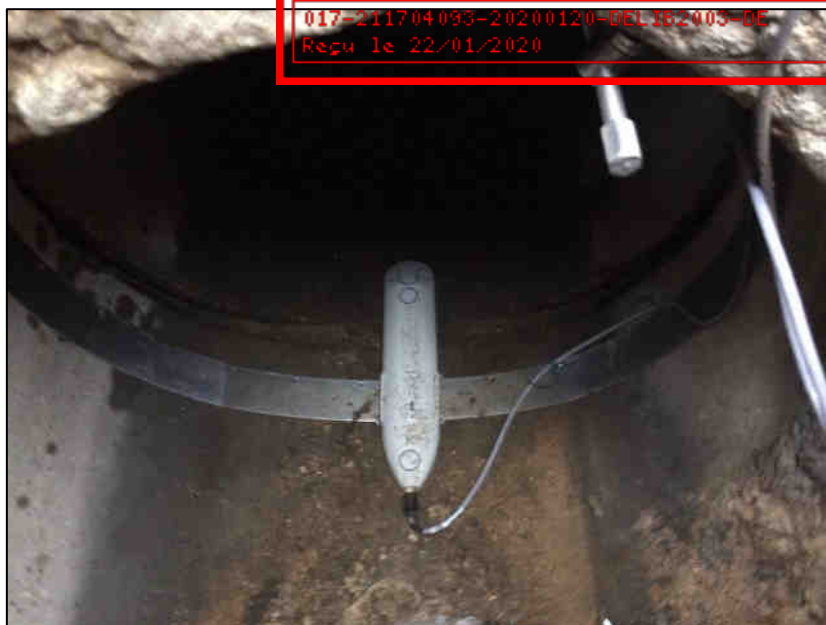
Figure 5 : prises de vue du pluviomètre et du débitmètre installés
