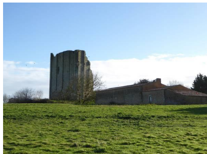
Vue sur la tour de Broue
