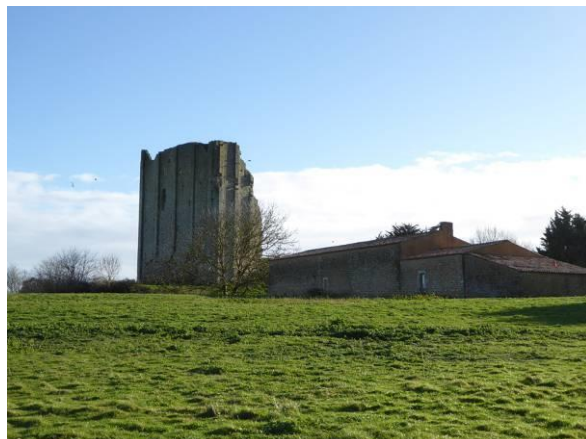
Vue sur la tour de Broue
