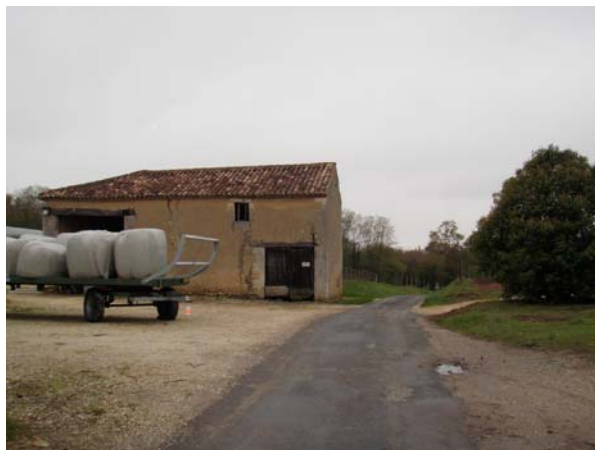
Grange – Bâtiment Ouest
