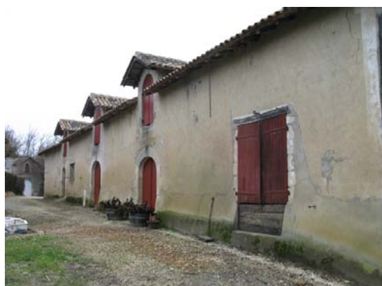
Chai (façade nord)
