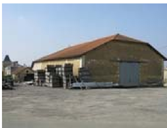
Anciennes écuries – bâtiment Nord (pouvant changer de destination)
