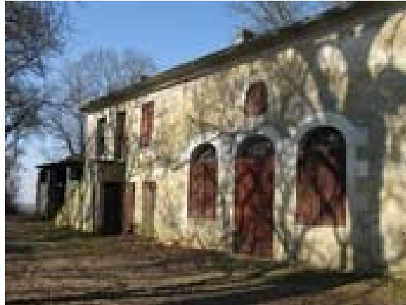
Etable et second logement de domestique – Extrémité Ouest Hangar vu depuis le sud-est
