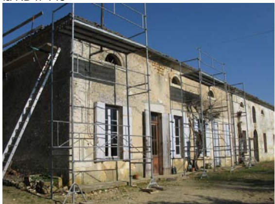
Logement de domestiques au nord vu depuis le sud-ouest
