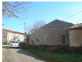
Vue des dépendances (ancien chai et toits) à l'arrière du logis de la Poupoterie
