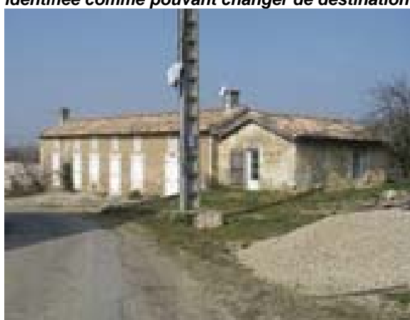
Logis des domestiques – bâtiment nord
