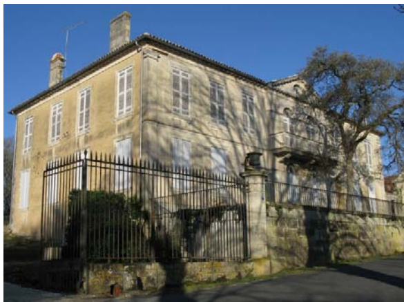
Logis de Saint-Sorlin – façade Est
