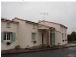
Vue de l'habitation au sud de la rue des Ajoncs
