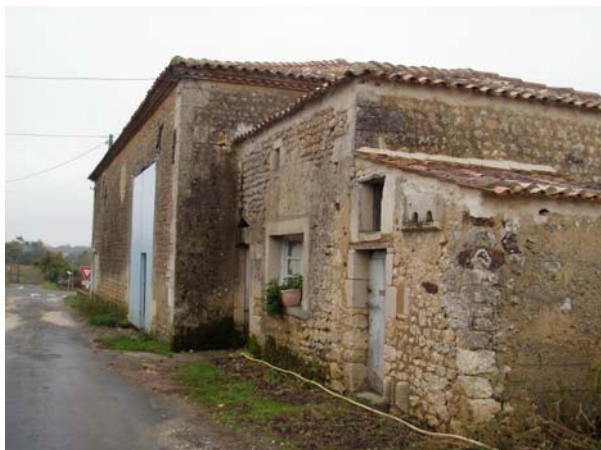
Grange, ancien logement d'ouvrier et soue – Bâtiment Est
