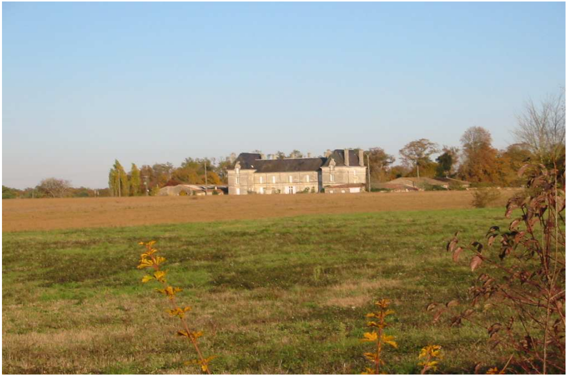
Photo 21 : façade sud du château de la Tillade
