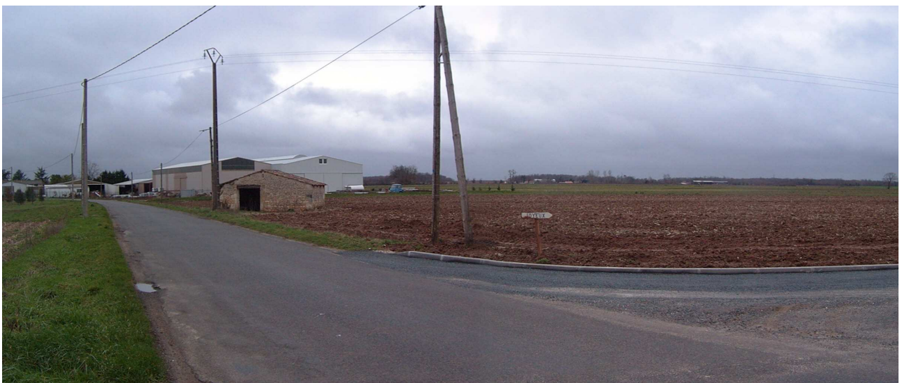
Photos 8 : l'entreprise CIPP : une insertion paysagère à rechercher
