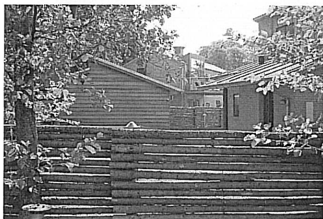
Barrières en bois naturel en limites séparatives Bureau d'Etudes PERNET
