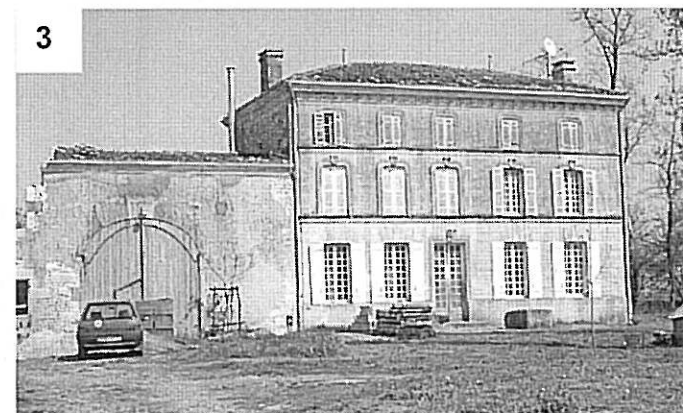
3 Maison de maître remarquable à La Ménarderie
