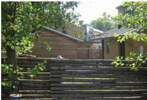
Barrières en bois naturel en limites séparatives
