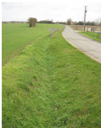
Fossé de la RD 125
