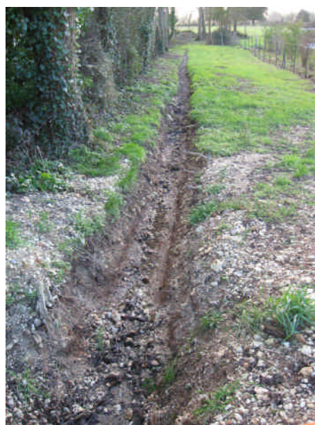
Fossé exutoire – RD 117
