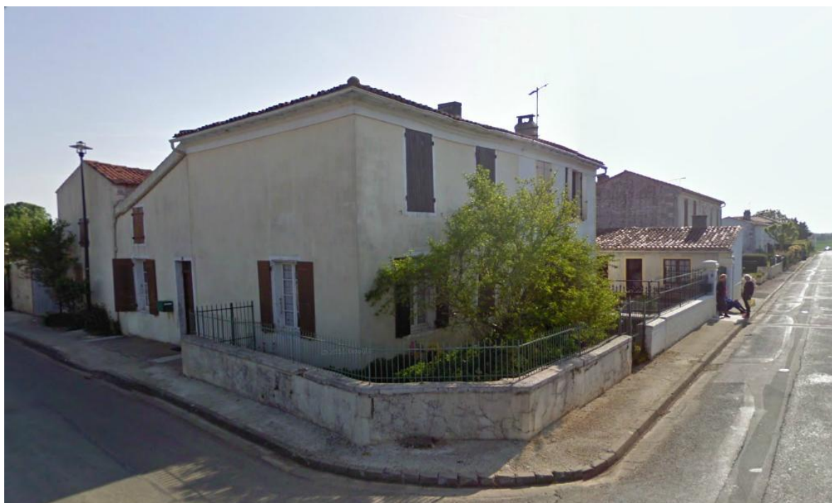
Murettes surmontées d'une grille
