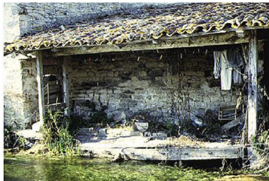
Le lavoir équipé d'un système de treillage manuel avec plancher mobile.
