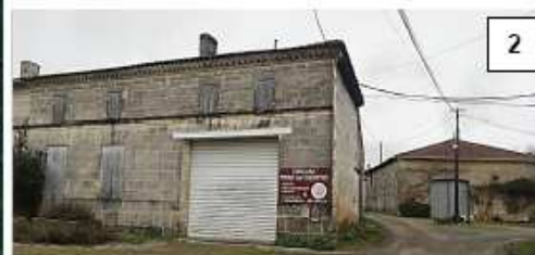
Bâti rural et agricole
