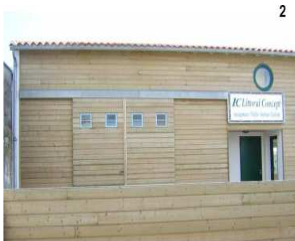
Bâtiment d'activité en bois
