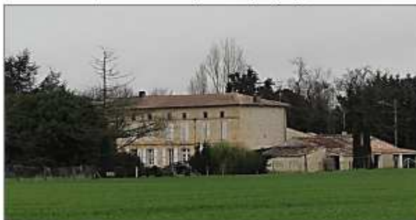
Imposante maison de maître dans le village de Phiolin (toiture à croupes, ouvertures carrées de combles, nombreuses ouvertures en façade, façade en pierre de taille).
