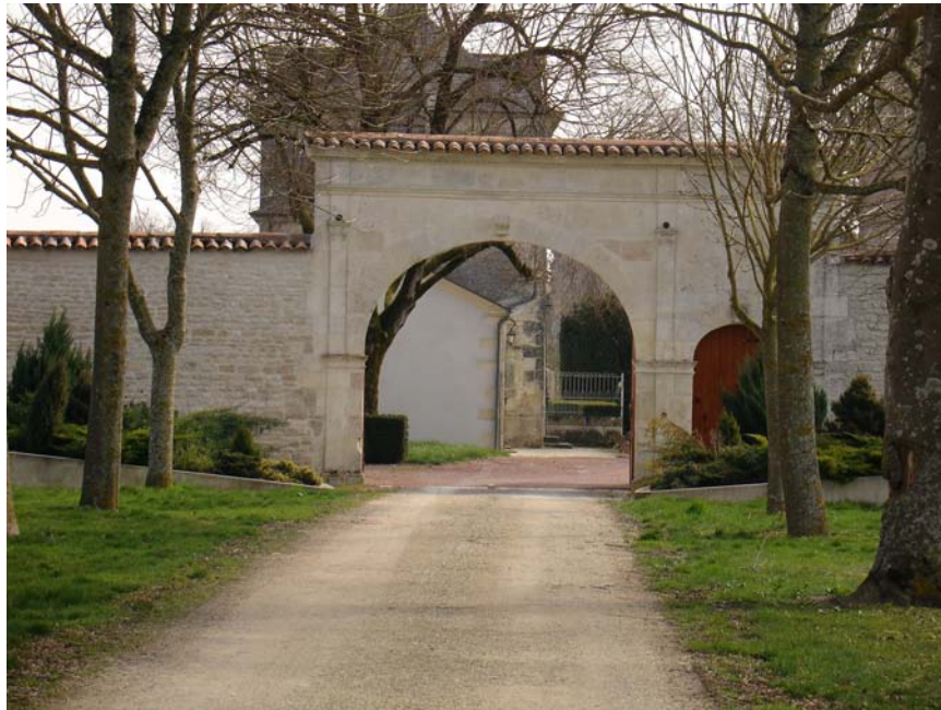
Porche – Logis, Les Rivières
