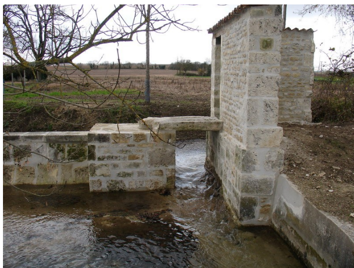
Déversoir – Les Rivières
