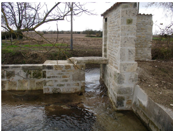
Déversoir – Les Rivières
