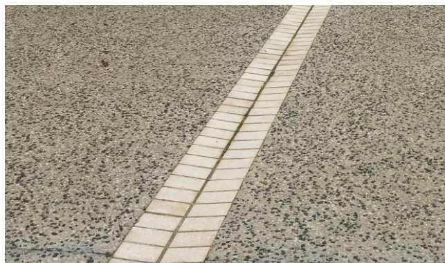
Caniveau pavé avec stabilisé
