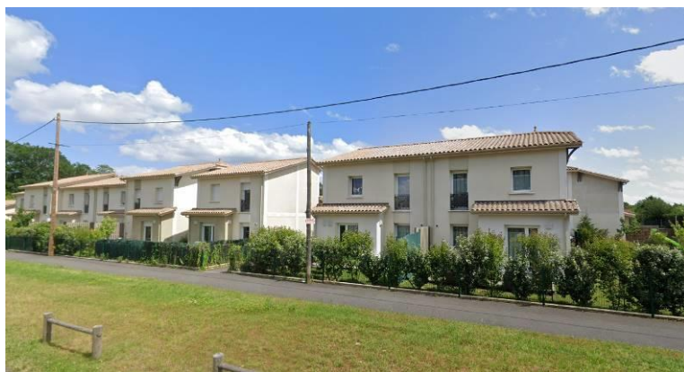
Ensemble de maisons individuelles « pures » et jumelées / R et R+1 (Cestas, 33)
