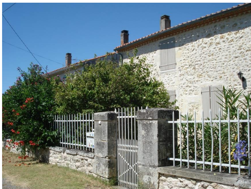
Mur traditionnels en moellons calcaires surmonté d'une grille sur la commune
