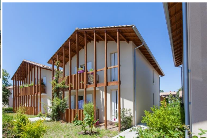
Habitat collectif – logements sociaux / R+1 (Lanton, 33)
