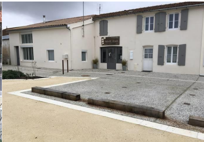
Parking aux places de stationnement marquées discrètement
