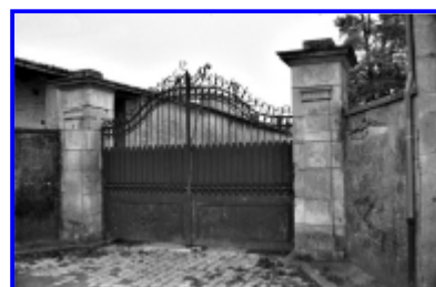
Fig. 6 Le portail à piliers de la cour de la ferme du logis, depuis le nord-ouest, 1990.
