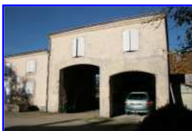
Fig. 19 Le passage couvert côté cour, depuis le sud-est.
