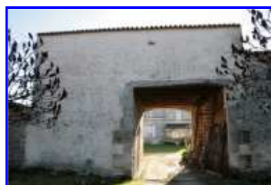
Fig. 20 Le passage couvert côté jardin, depuis le nord-est.
