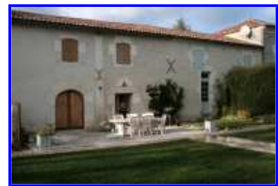
Fig. 3 Le logement à pièce unique et les dépendances accolées à gauche, depuis le sud-est.
