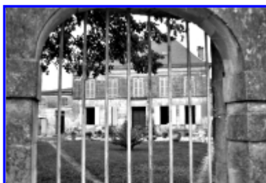
Fig. 1 Le logement, depuis le sud-ouest, 1990.
