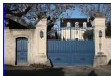
Le portail à piliers et le logement, depuis le sud-ouest.
