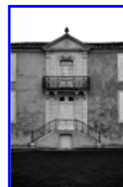
Fig. 3 L'avant-corps du logis, depuis le nord-est, 1990.
