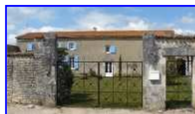
La façade sur cour du logement et le portail, depuis le sud.
