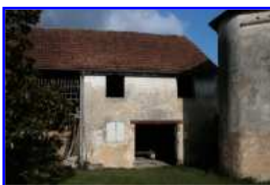
Fig. 19 L'ancienne étable accolée à un hangar, depuis le sud-ouest.
