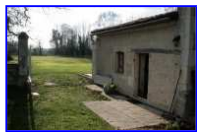
Fig. 6 La servitude placée à l'extrémité du premier corps et le deuxième portail à piliers, depuis le nord- est.
