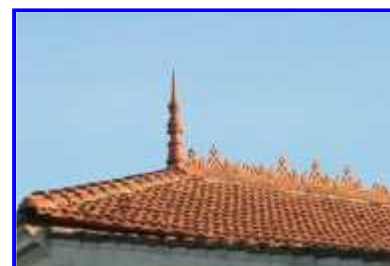
Fig. 6 La crête et un épi de faîtage, sur la toiture du logement.
