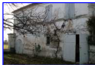
Fig. 15 Le chai accolé à gauche du logement principal, depuis le nord-est.
