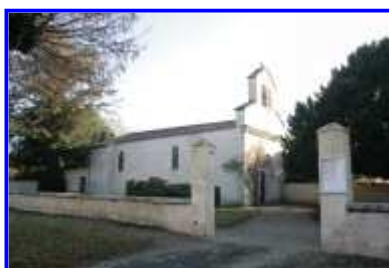
Fig. 7 L'église, depuis le nord-ouest.
