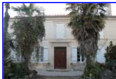
Fig. 2 La façade sur cour du logement, depuis le sud-est.
