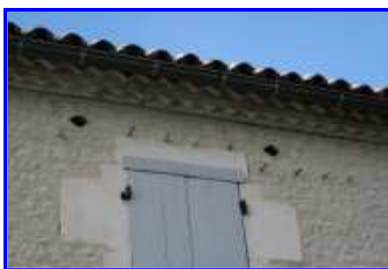
Fig. 4 La double génoise et les creux à moineaux du logement à pièce unique, depuis le nord- est.
