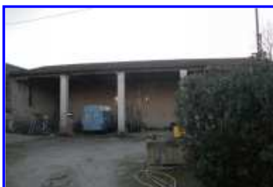
Fig. 7 Le hangar agricole, depuis le nord-ouest.
