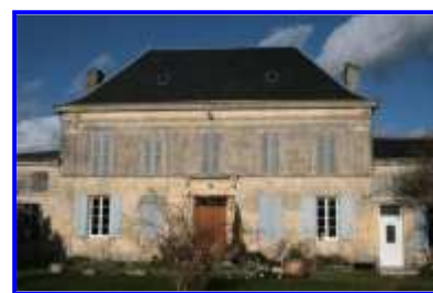
Fig. 3 La façade sur cour du logement, depuis le sud-ouest.
