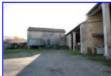
Fig. 17 Les hangars agricoles et une dépendance en retour, dans la cour de l'autre côté de la rue, depuis le nord-est.
