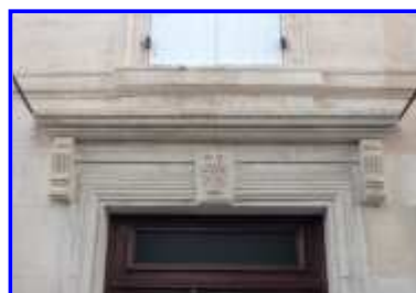
Fig. 5 Un détail de la porte du logement, depuis le sud-est.
