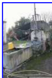
Fig. 8 Le puits, depuis le nord-est.
