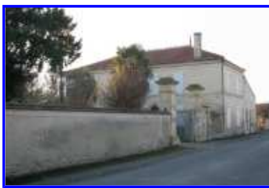
Fig. 1 Une vue d'ensemble de l'ancienne ferme, depuis le nord-est.
