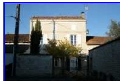
Le premier logement de l'ancienne ferme, depuis le sud-ouest.
