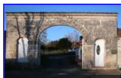
Le portail couvert, depuis le sud-ouest.
