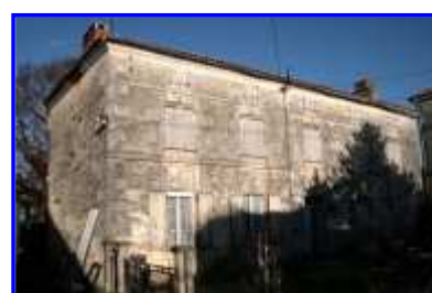
Le logement principal de la ferme, depuis le sud-ouest.
