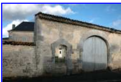
Fig. 7 Le portail couvert et le logement, depuis le sud-ouest.
