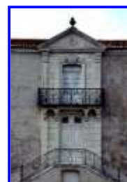
Fig. 9 L'avant-corps du logis, depuis le nord-est, 1999.
