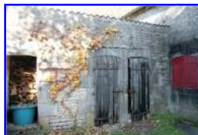
Fig. 18 Des toits à bêtes, depuis le sud-ouest.
