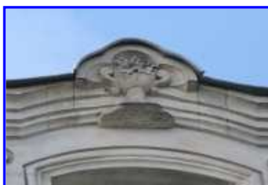
Fig. 13 Une agrafe sur la lucarne centrale du comble.
