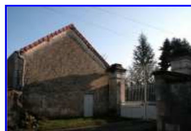
Fig. 24 Le portail à piliers côté impasse, depuis le nord-ouest.
