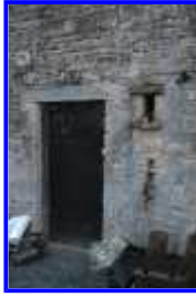
Fig. 22 Une porte d'une des dépendances de la ferme, depuis le sud-est.
