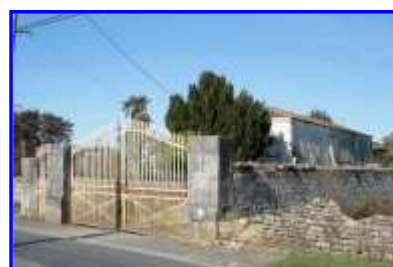
Une vue de l'ancienne ferme, depuis sud-est.
