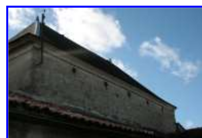
Fig. 6 La façade arrière du logement, depuis le nord-est.
