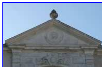
Fig. 12 Le fronton triangulaire de l'avant-corps du logis, depuis le nord-est.
