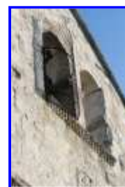
Fig. 15 Les deux baies du campanile, depuis le nord-ouest.
