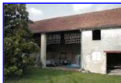
Fig. 20 Un des hangars agricoles de l'ancienne ferme, depuis le sud-est.
