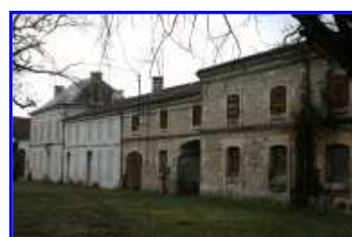
Une vue des logements et des dépendances accolées à droite, depuis le nord-est.
