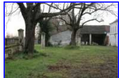
Fig. 6 Le hangar à piles maçonnées carrées et un portail à piliers, depuis le nord-ouest.
