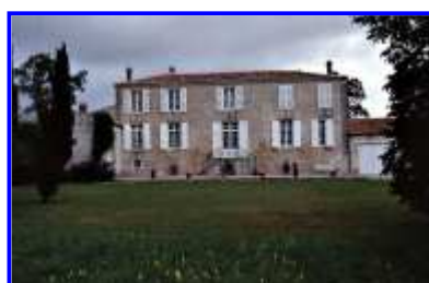
Fig. 8 La façade arrière du logis, depuis le sud-est, 1999.
