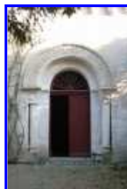
Fig. 10 Le portail, depuis l'ouest.
