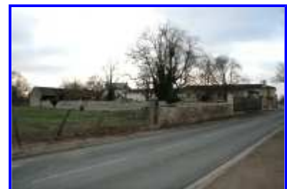
Fig. 3 Une vue d'ensemble de l'ancienne ferme, depuis le nord-est.
