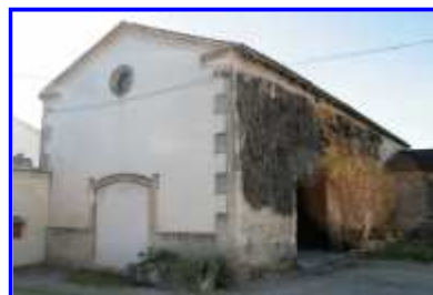
Fig. 11 Un des hangars de la propriété, depuis le nord-est.
