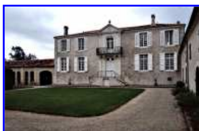
Fig. 7 La façade sur cour du logis, depuis le nord-ouest, 1999.
