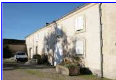
Fig. 13 Le bâti en retour des chais, depuis le sud-est.
