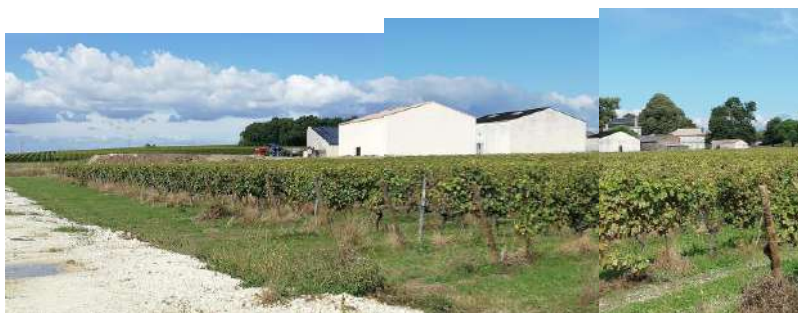
vue sur les chais depuis le chemin d'accès sud
