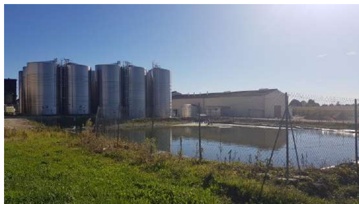
Bassin incendie sur le site de la distillerie de la Bertonnière (Eau-Méga, 2021)
