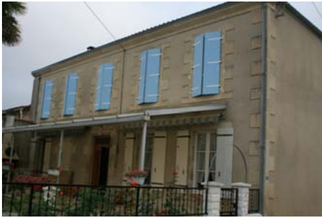
Date sur façade de maison, La Petite Vaillette
