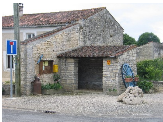
Espace public à Gâtébourse
