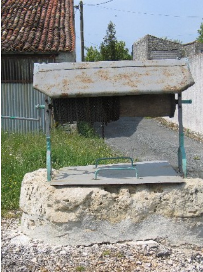
Ce puits communal aux Loges dispose d'une pierre de taille monolithe.
