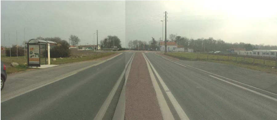
RD 728 : en venant de Marennes, giratoire d'entrée de Saint Just et de Luzac
