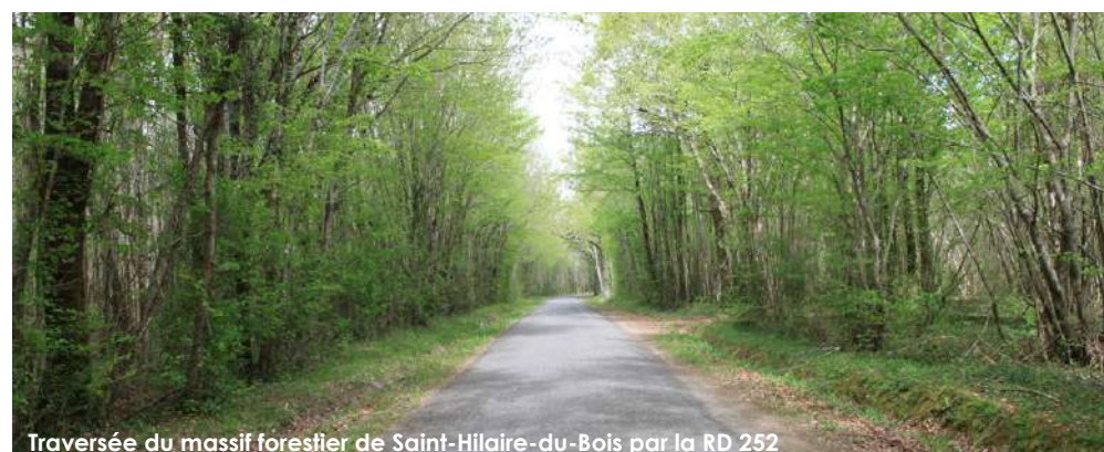
Traversée du massif forestier de Saint-Hilaire-du-Bois par la RD 252
