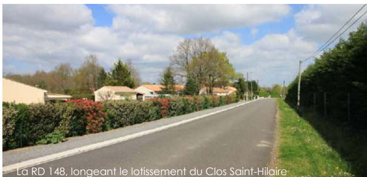
La RD 148, longeant le lotissement du Clos Saint-Hilaire
