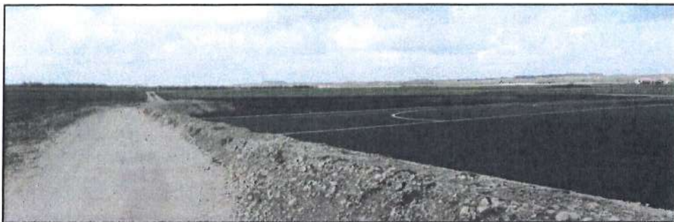
Vue 4. Vue d'ensemble sur la piste récemment aménagée en partie Nord de la pépinière (parking avions), avec en arrière-plan les terrains de la future zone d'activité. Le chemin d'exploitation sera déplacé sur le contour Ouest de la zone. La topographie est quasiment plane. Les actuels champs cultivés ne comprennent aucune végétation arbustive ou arborée.
