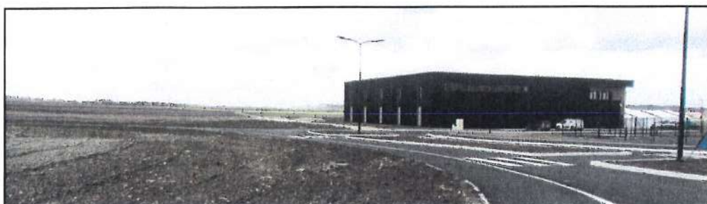
Vue 3. Vue d'ensemble sur la partie Sud de la zone 1AUg comprenant l'accès et un futur hangar implanté dans la continuité de la pépinière.
