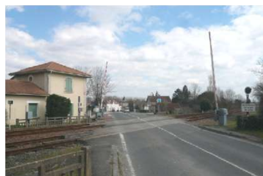
Passage à niveau sur la D2
