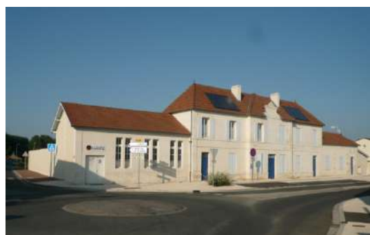
Aménagement urbain avenue de l'Europe - résidence Polignac
