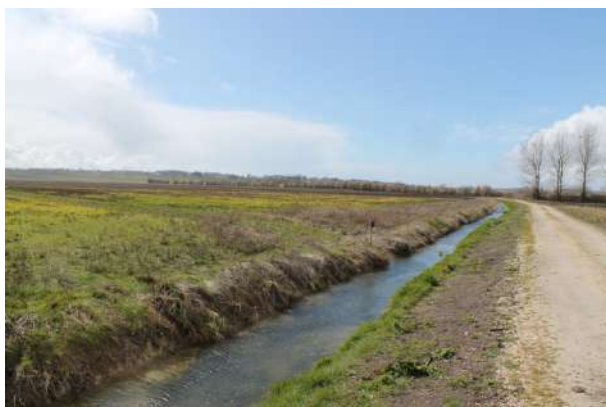
Fossé de drainage
