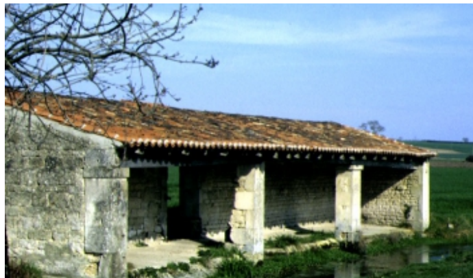
Lavoir en pierres de taille et en moellons dont le toit en appentis repose sur trois poutres en appuis sur deux piliers, au bord du cours d'eau Le Batailler
