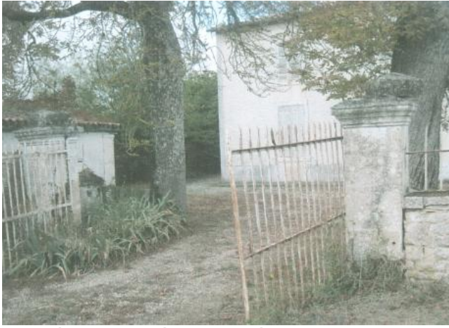
Portail à piliers carrés, rue de l'église
