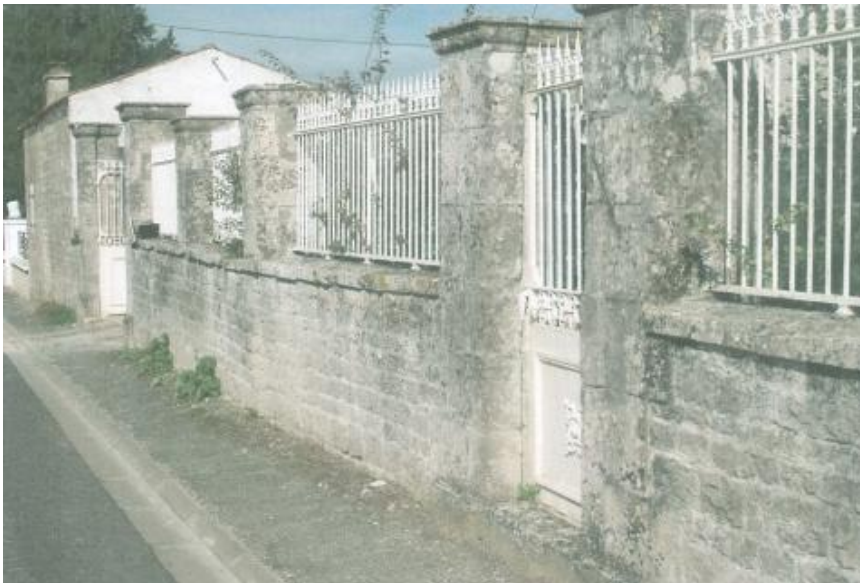
Portail et porte en fer forgé, soutenus par des piliers carrés en pierre de taille, rue de Dampierre
