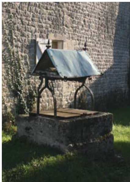
Puits avec toit disposant d'épis de fâitage, rue du Vieux Puits
