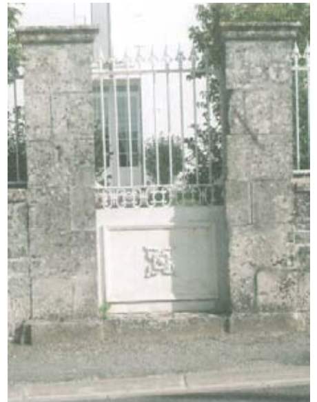
Porte piétonnière soutenue par deux piliers carrés, rue de Dampierre
