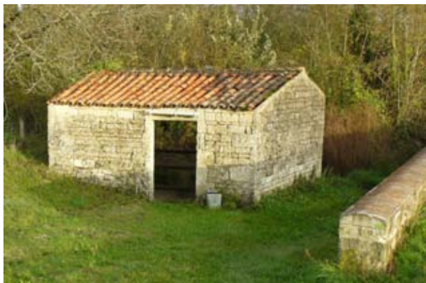
Lavoir recouvert de tuiles creuses ayant longtemps servi aux lavandières, Batailler
