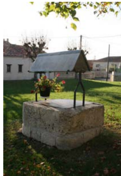
Puits à margelle en pierres de taille, place de l'église
