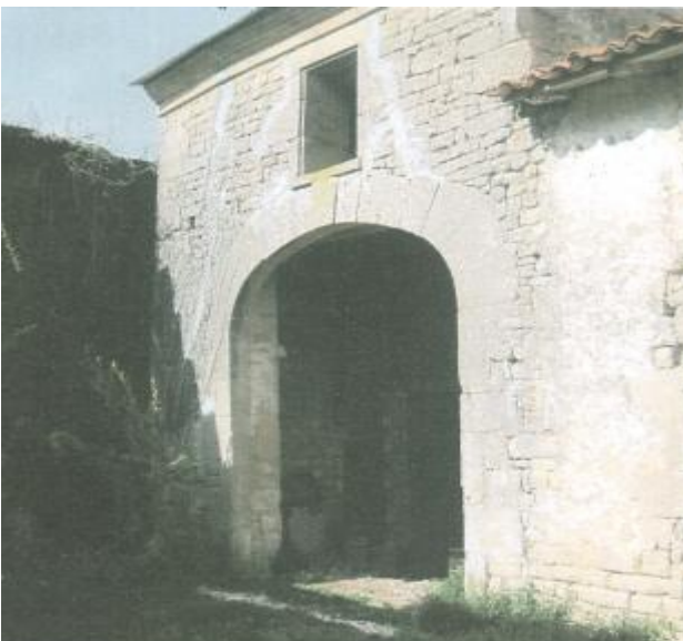
Porche surmonté d'un linteau à claveaux et fenêtre à linteaux délardés, rue du Gué à Chauvin
