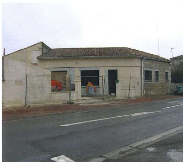
Chantier route de Jonzac
