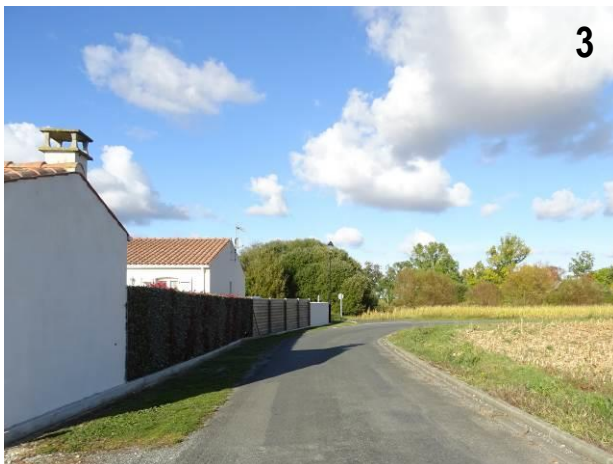
Frange non qualitative par son traitement hétérogène : bâti tournant le dos à la route et à l'espace agricole, haie d'essences horticoles, clôture en bois, muret enduit
