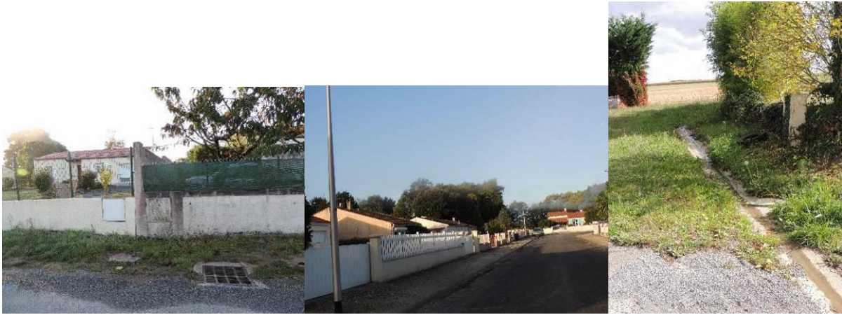
Exemple de bordures de routes et de caniveau
