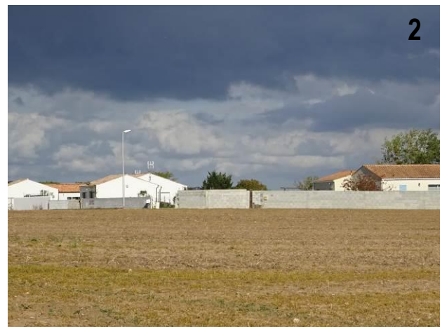
Mur non enduit et absence de transition entre les constructions et la route
