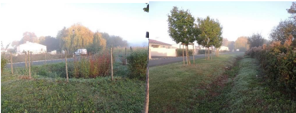
Bassin de rétention et noue Chez Jean-Maître
