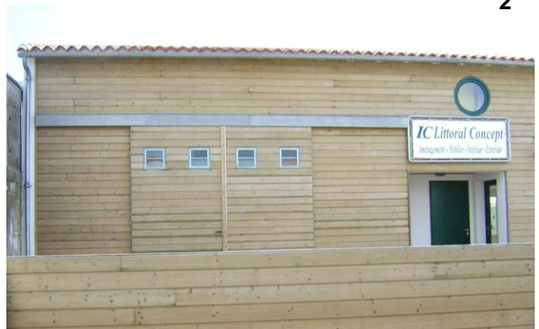
Bâtiment d'activité en bois
