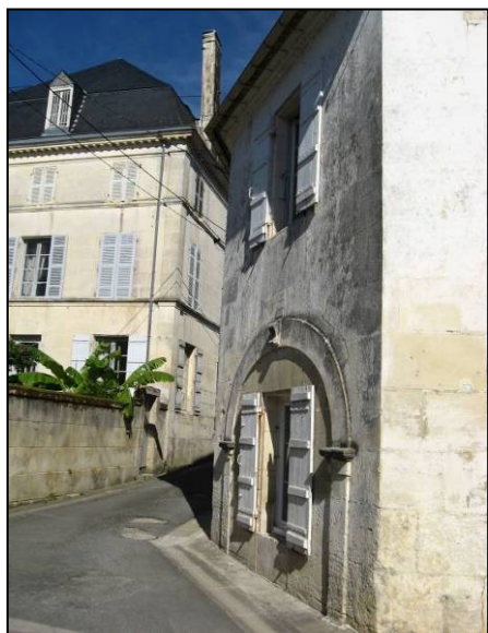
Bâties anciens autour du moulin
