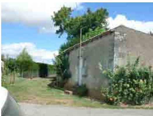
Les pieds de murs sont habillés par la végétation
