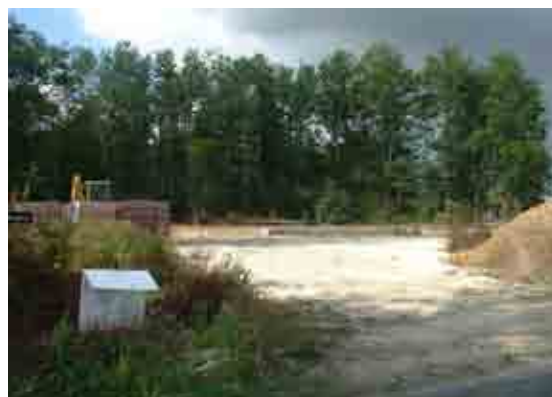
Maison en construction au Poteau
