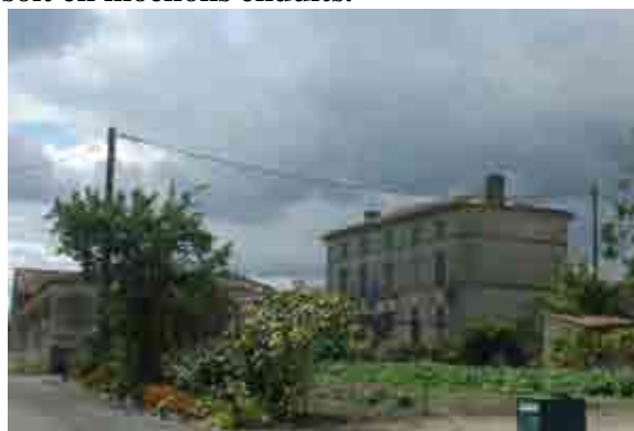
Maison en pierre de taille calcaire, toitures en tuiles canal, étage mansardé et dépendances, Chez Billon
