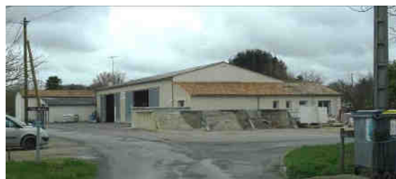
Entreprise de maçonnerie
