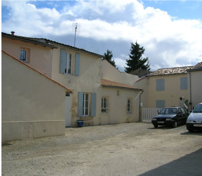
Opération (3 logements) située place de l'Amitié
