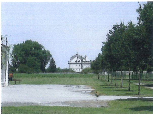
Vue sur le château depuis le bourg (arrière de la salle des fêtes)
