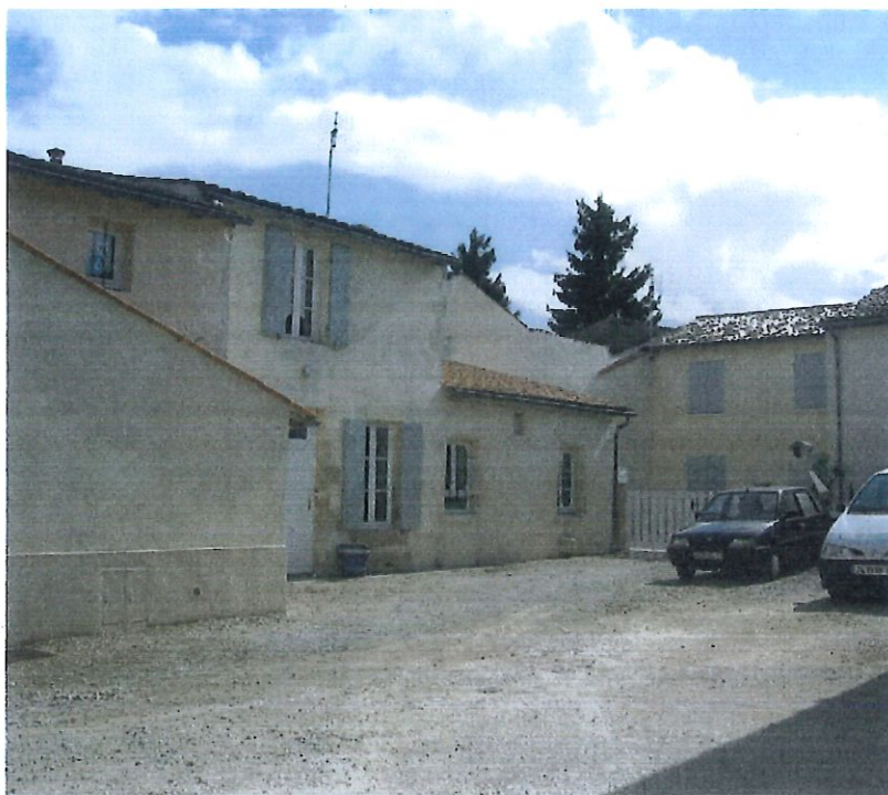
Opération (3 logements) située place de l'Amitié
