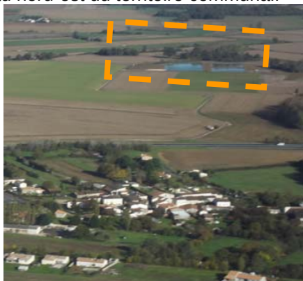
Station d'épuration de la commune au nord-est du territoire
