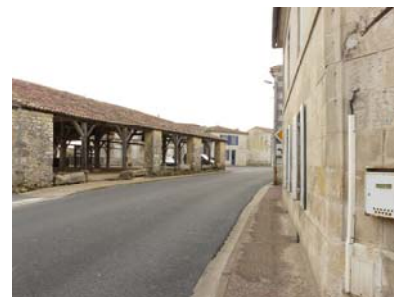
Route départementale RD 127 – rue Jean de Vivonne
