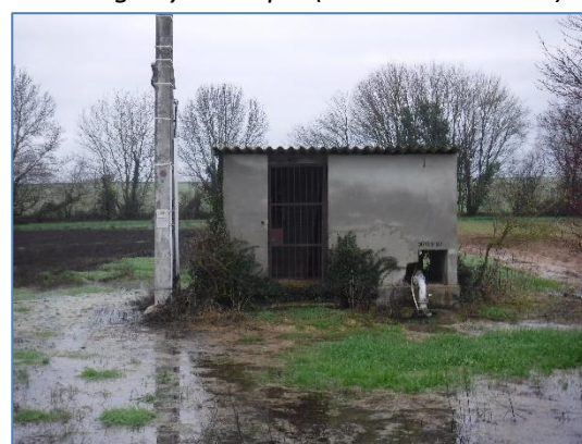
Station de pompage (« La Martinière »)
