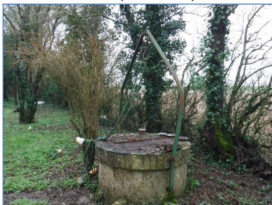
Puits (« Fief le Treuil »)
