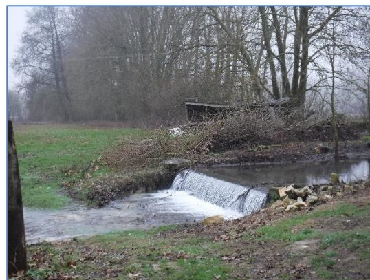
Ouvrage hydraulique (« Les Rousseaux »)
