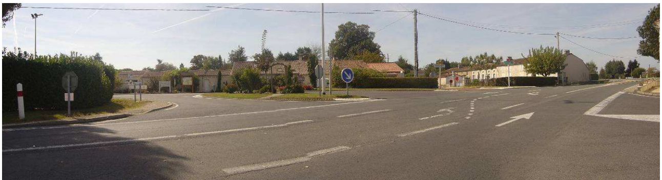
Carrefour d'entrée principal du bourg, très minéral et insuffisamment sécurisé
