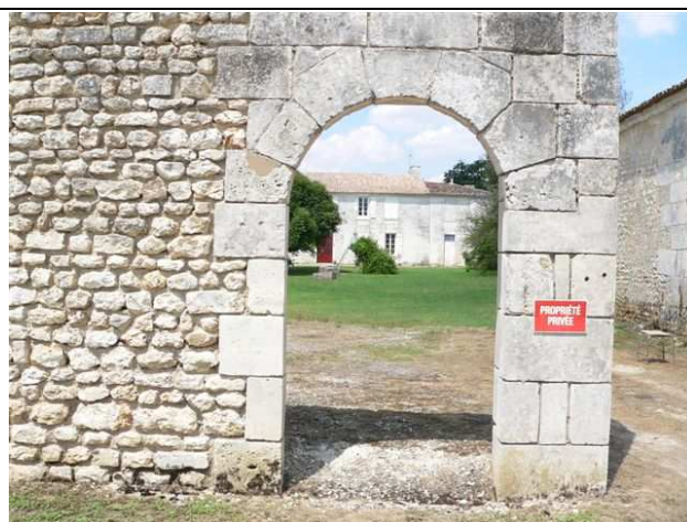
(9) : Bâtiment de ferme à Montravail :
