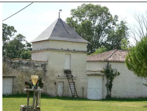
(12) : Bâtiment de ferme au Profondeau :
