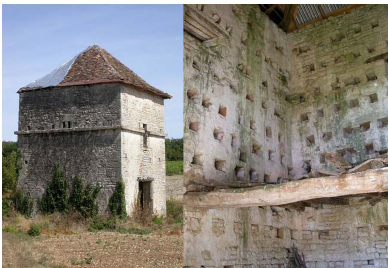
Vues extérieures et intérieures du pigeonnier du Puycerteau
