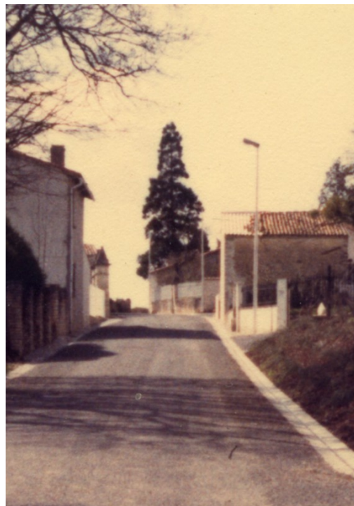
RD 230 au village La Roche après rescintement
