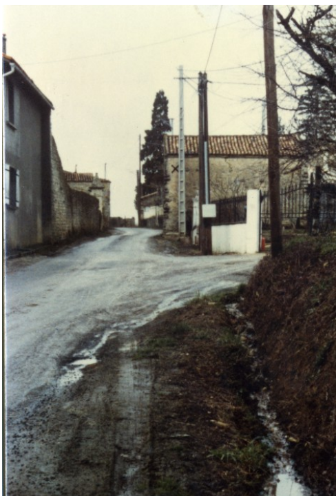
RD 230 au village La Roche avant rescintement
