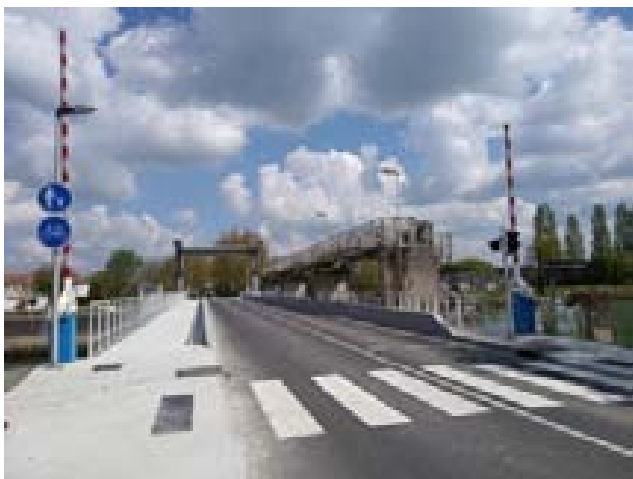
Nouvelle passerelle cyclo-pedestre
