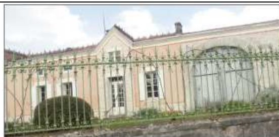
Petite maison atypique dans le hameau de Bapaille de la fin XIXème ou début XXème avec toiture munie d'une frise en terre cuite. Beau porche cintré en pierre.
