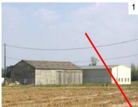
A droite : hangar agricole métallique avec un bardage blanc clair, et donc très visible en hiver (sols nus). A gauche : bâtiment agricole en bois avec toiture métallique de la même teinte. Grande discrétion, même en hiver.
