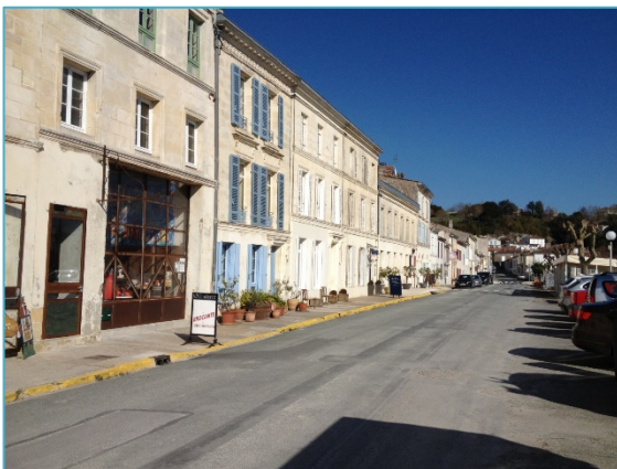
Le front bâti le long du quai de l'Estuaire
