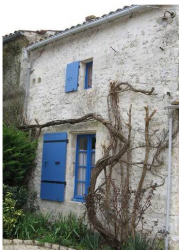
Exemple de maison à l'architecture traditionnelle : façade ordonnancée en moellons enduits. Elle est rythmée par des ouvertures plus hautes que larges et des trous de pigeonnier, Les Vallières
