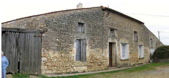
Constructions en moellon, les dépendances se trouvent en appentis, Mazerolles
