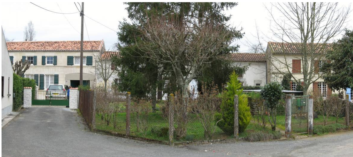
Alignement de maisons à l'architecture traditionnelle au centre du village
