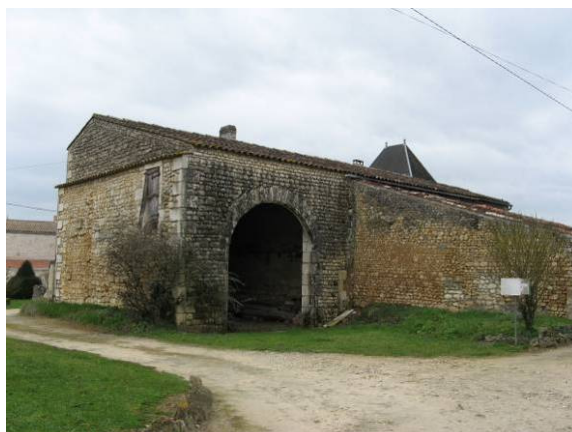
Seule habitation ayant un toit d'ardoise sur la commune. Ce logis présente une façade bien ordonnancée en pierre de taille. Les dépendances, principalement en appentis sont en moellon. Un porche permet d'entrée dans la propriété. Comme dans la plupart des propriétés se trouve un puits.
