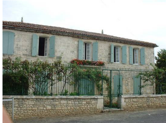
Clôture constituée d'un muret et de grilles ; ici aussi la végétation est présente
