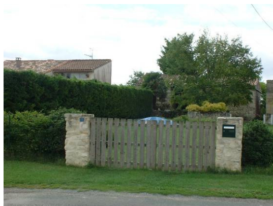
Portail bois simple, piliers en moellons et haie en clôture
