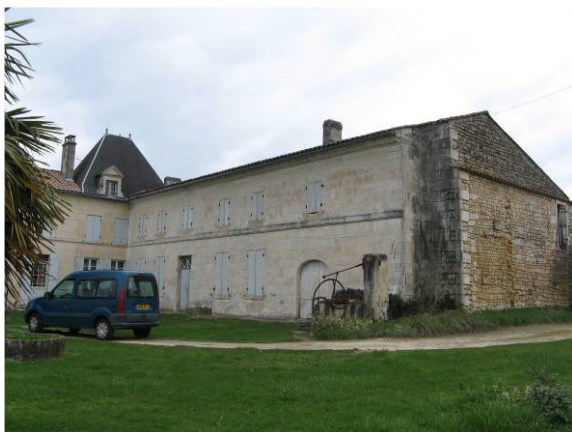
Seule habitation ayant un toit d'ardoise sur la commune. Ce logis présente une façade bien ordonnancée en pierre de taille. Les dépendances, principalement en appentis sont en moellon. Un porche permet d'entrée dans la propriété. Comme dans la plupart des propriétés se trouve un puits.
