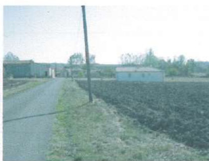
Entrée du village et construction récente
