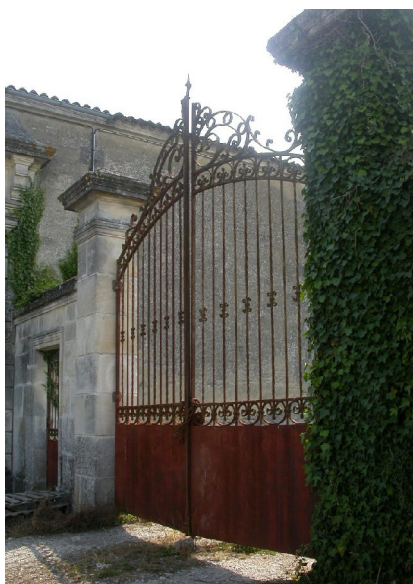
Portail encadré de deux piliers carrés en pierre de taille surmonté de chapiteaux moulurés. Grille finement ouvragée. (Malemont)
