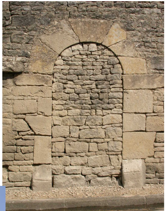
Porte murée en plein ceintre
