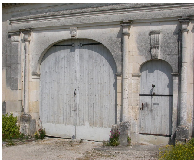
Portail richement orné, qui comprend une corniche à modillons, des petits piliers ronds, des pilastres et des clés de voûte saillantes. (rue des vallées dans la bourg)
