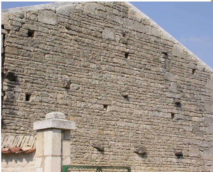
Mur en moellon habillé de creux de chaffaud (qui permettaient de fixer les échafaudages) et pierres à litre (qui symbolisaient une bouteille de vin offerte par le patron)
