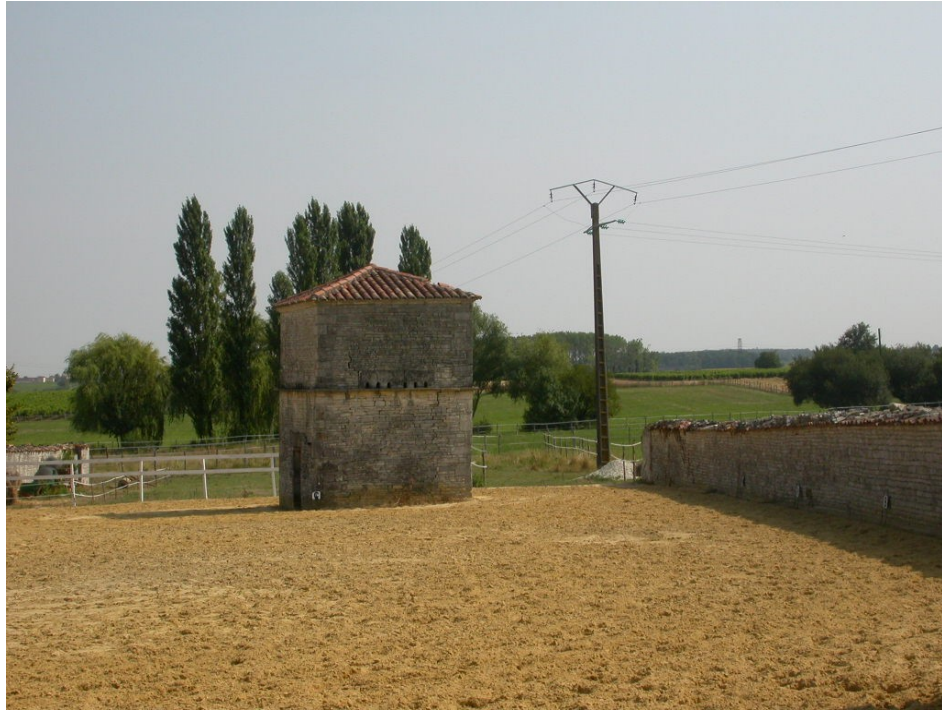
Pigeonnier carré se situant dans une ferme à Virollet. Surmonté d'un toit en pavillon recouvert de tuile creuse. Pierre d'envol et trous à pigeons sur la façade.
